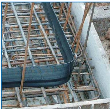
X Kontrolna traka široka je 2,5 cm i postavlja se na visini od 2,5 cm do 5 cm. Ona služi za određivanje i kontrolu dubine ugradnje. Maksimalna ugradbena dubina profila s bubreæomgumom iznosi 5 cm.
