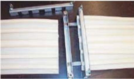
II. Pomoæuoštrog noža odrežite obje strane koje treba zavariti i to ravno i popreèno. Zatim krajeve profila postavite tako da s obje strane preostaje 10 mm trake fuge.
